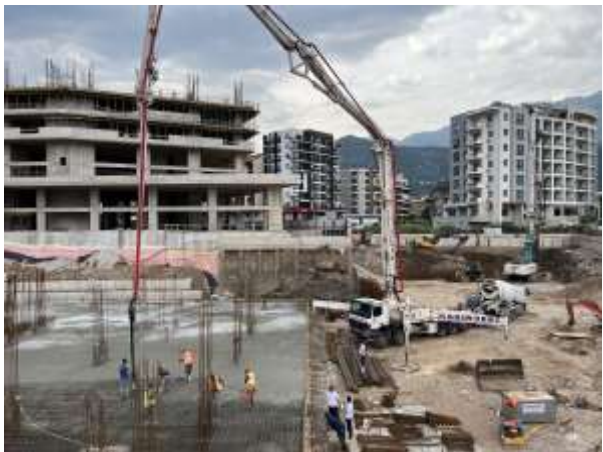
/betooni paigaldamine ehitusobjektil/
